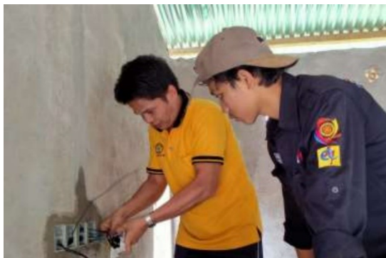
Gambar 4. Pemasangan Saklar dan Stop Kontak
