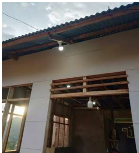
Gambar 7. Pengetesan Intalasi Listrik
