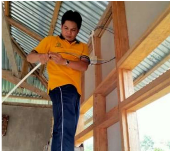
Gambar 3. Pemasangan Jaringan Instalasi
