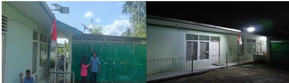
Gambar 3. PJU Tenaga Surya 300 Watt di Pustu Jawa Gadut saat Kondisi Cerah dan Kondisi Gelap.
