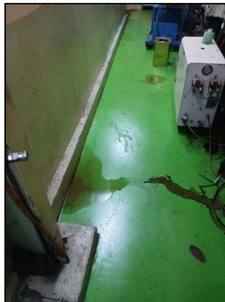
Gambar 2. Lantai Bergelang Air/Pelumas pada Area Kerja
