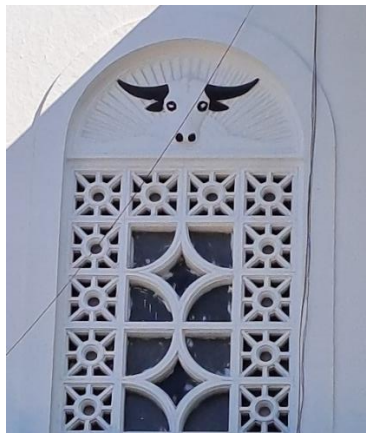
Gambar 8. Ventilasi Menara Jam Gedung
