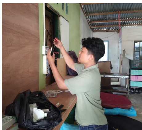
Gambar 3. Instalasi dan Perbaikan Aliran Listrik di Panti
