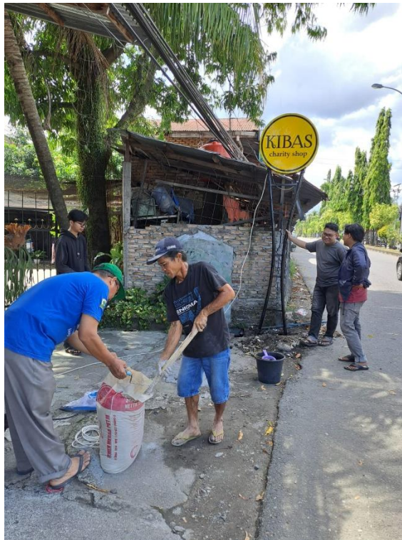
Gambar 4. Pemasangan Neon box
