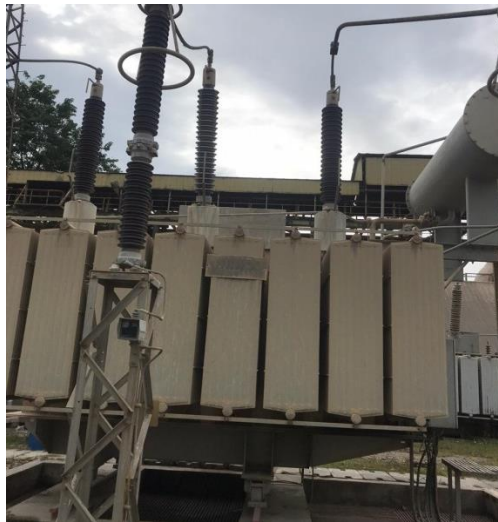
Gambar 5 Transformator sebelum dipasangkan fan
