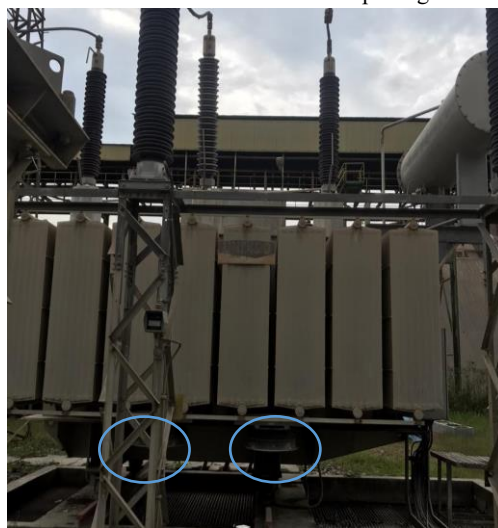
Gambar 6. Transformator setelah dipasangkan fan
