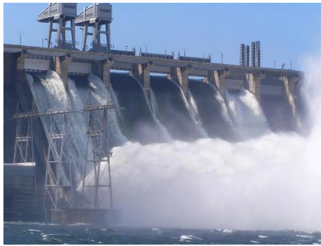
c) Bendungan PLTA [10]
