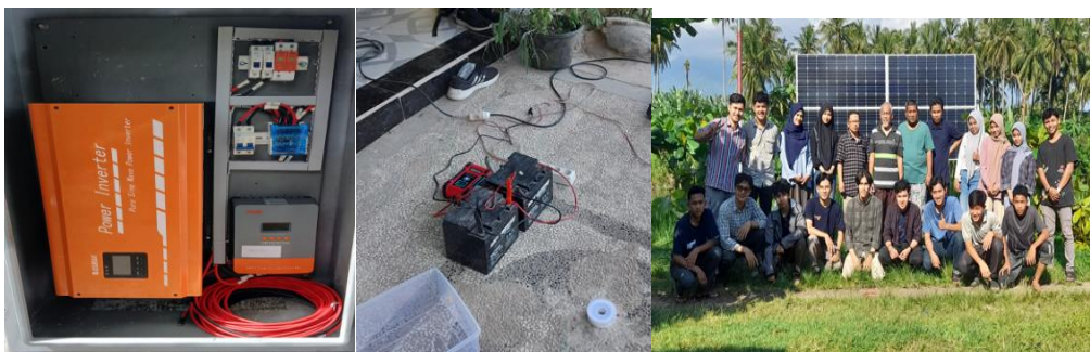
Gambar 5. Proses pemasangan dan pemanfaatan energi dari solar cell
