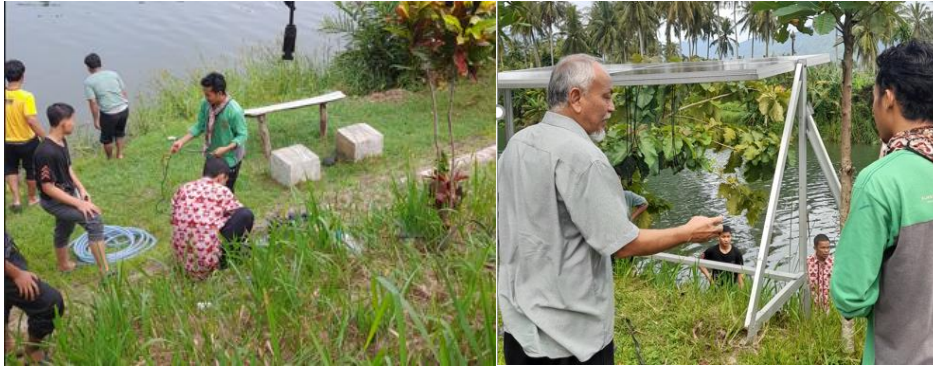
Gambar 4. Proses pemasangan pompa air secara otomatis
