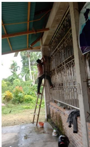
Gambar 1a. Teknisi sedang melakukan Instalasi jaringan Wifi Router di Mushalla
