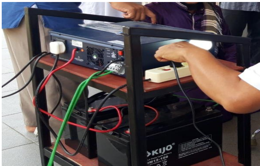
Gambar 3. Pemasangan alat di Pondok Pondok Tahfidz Darul Hijrah Wal Amanah
